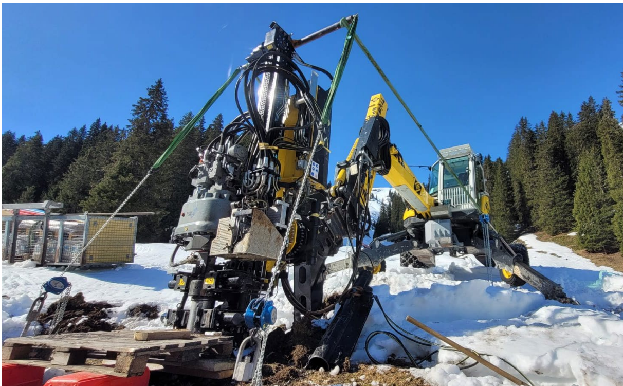
Abb.9: Einsatz der Kernbohrlafette montiert auf einem Schreitbagger
