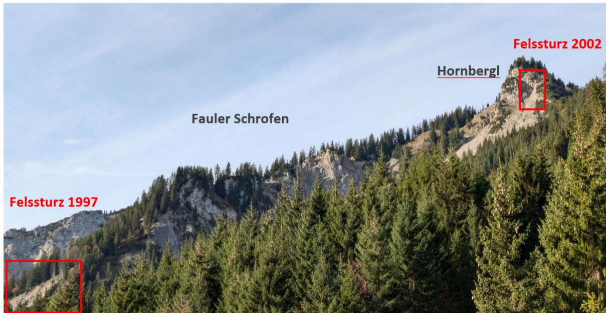
Abb. 1: Orographisch rechte Seite des Talschlusses des Murenbachs mit Faulem Schrofen und Hornbergl. Rot markiert: Abbruchgebiete der jüngsten Felssturzereignisse.
