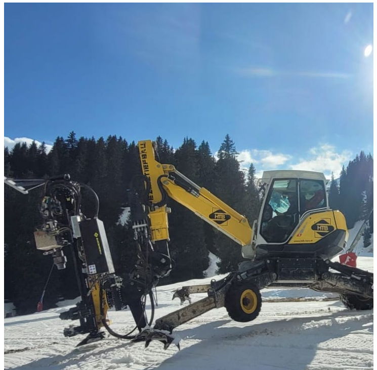
Abb.2: Kernbohrlafette auf Schreitbagger
