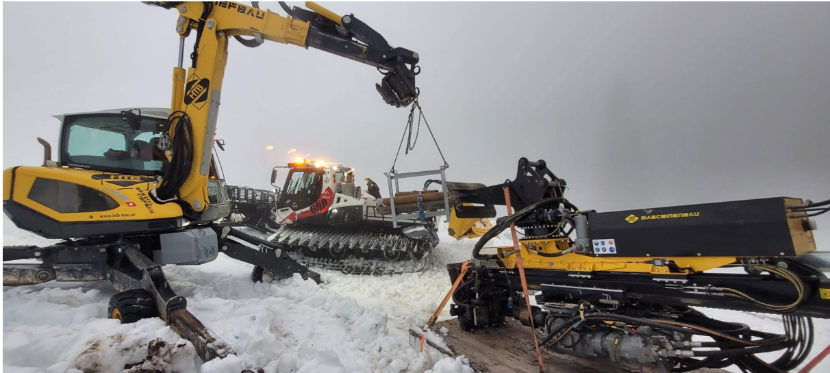
Abb.8: Antransport der Kernbohrungsgerätschaften zum Einsatzort
