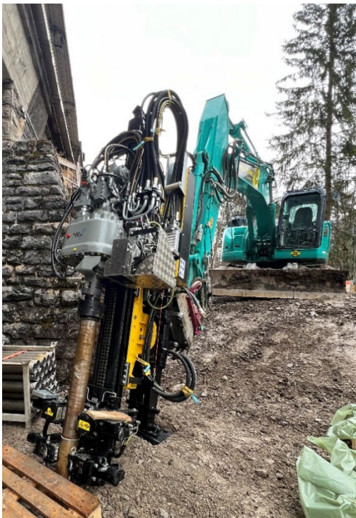
Abb. 1: Kernbohrlafette auf Raupenbagger
